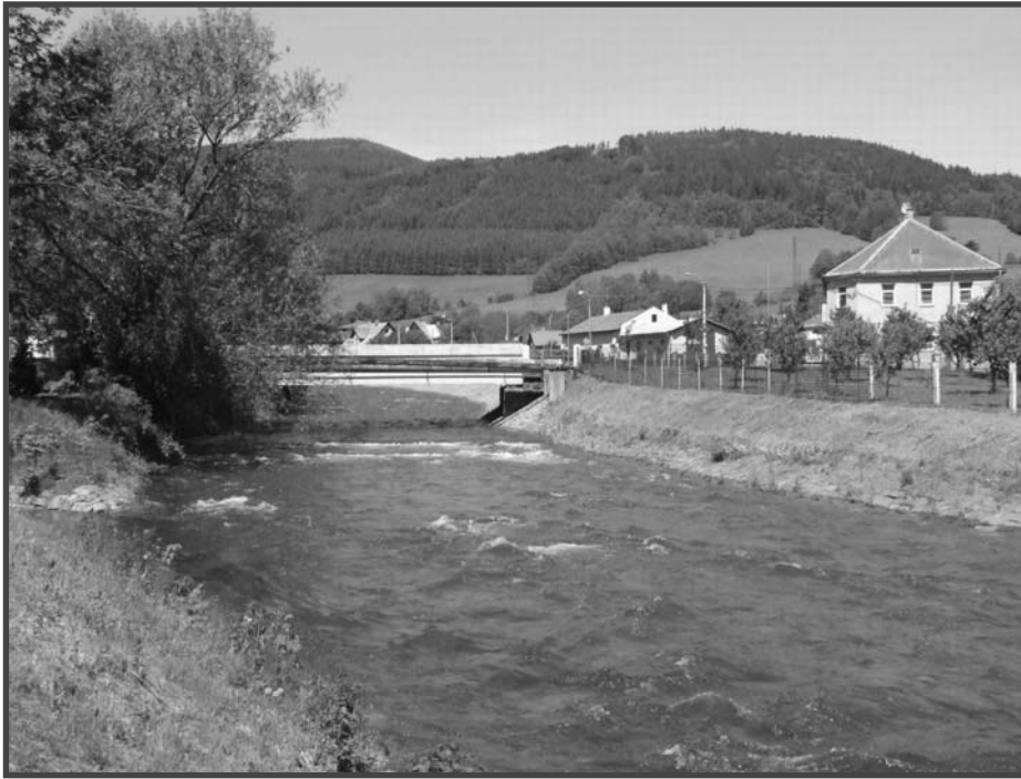
3b) Most u „Pozinkovny“ byl postaven v roce 1933. Dovolené zatížení - parní válec o 14 000 Kg. Rovnoměrné zatížení 400 Kg/m 2 . Provedeno firmou Ing. Emil Lindenthal - Terezín.
