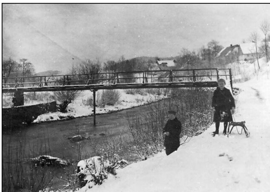
5a) Einstiger Fabriksteg (bývalá tovární lávka). Foto H. Kupetz.
