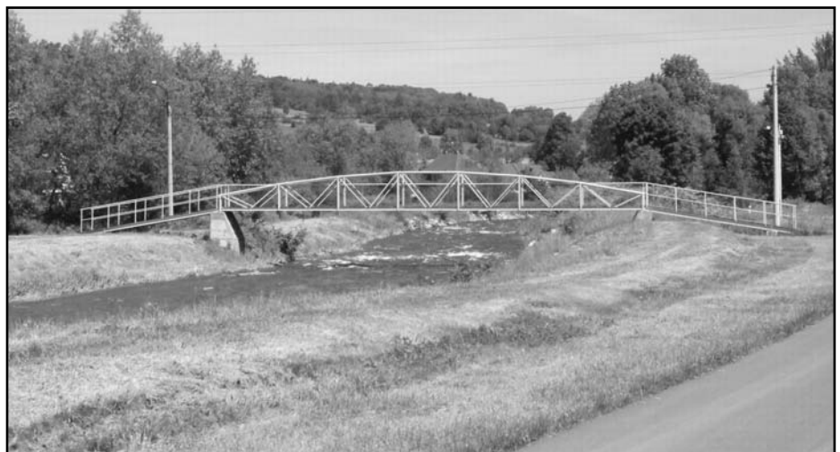
7b) Lávka pod ČOV, fotografie pořízena v roce 2010. Foto R. Janas.
