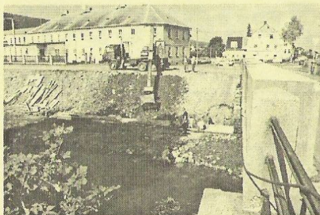
Rychle postupuje úprava břehů řeky Bělé. Stav na konci sprna...
