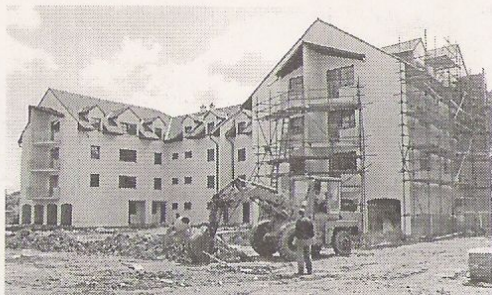
Zadní trakt rozestavěného bytového domu
