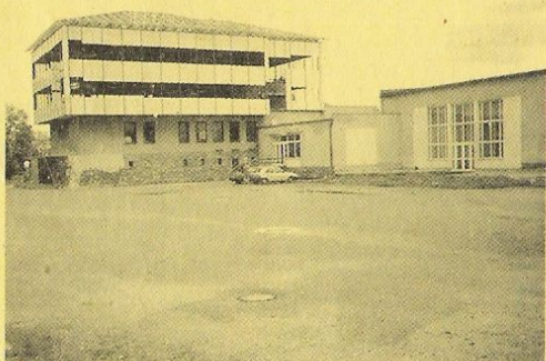
Nad hotelem „Zlatý Chlum“ se již rýsuje nová střecha
