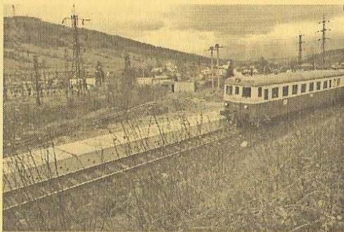
Na nové zastávce ČD se již rýsuje nástupiště
